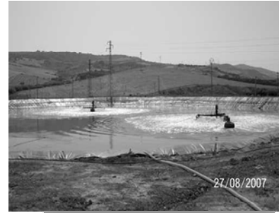
ภาพที่ 3 ระบบบำบัดน้ำเสียแบบบ่อเติม อากาศ ที่มา (WPL, 2010)
