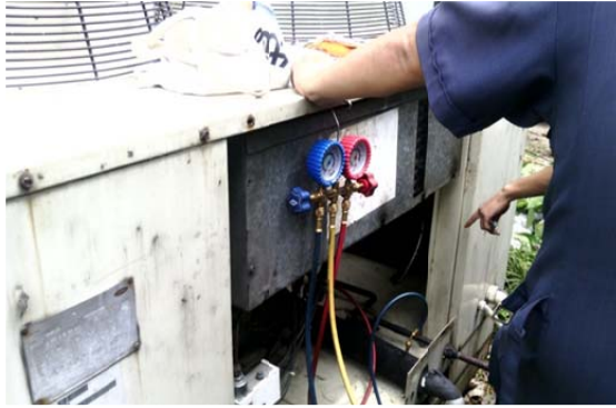
รูปที่ 2 การเติมสารทำความเย็นระบบทำความเย็น
