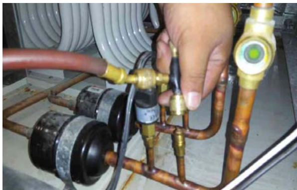
รูปที่ 10 การถอดวาล์วบริการต้นแบบ
