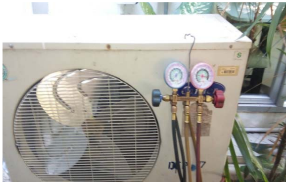
รูปที่ 3 การต่อสาย Pressure Gauge
